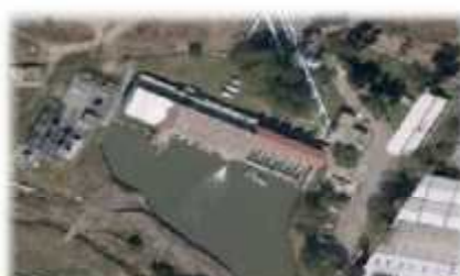
Planta de bombeo No. 2
