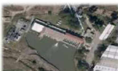
Planta de bombeo No. 2
