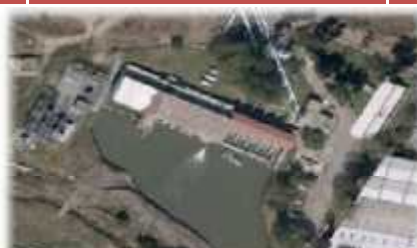
Planta de bombeo No. 2
