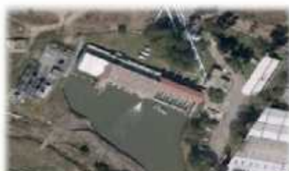
Planta de bombeo No. 2
