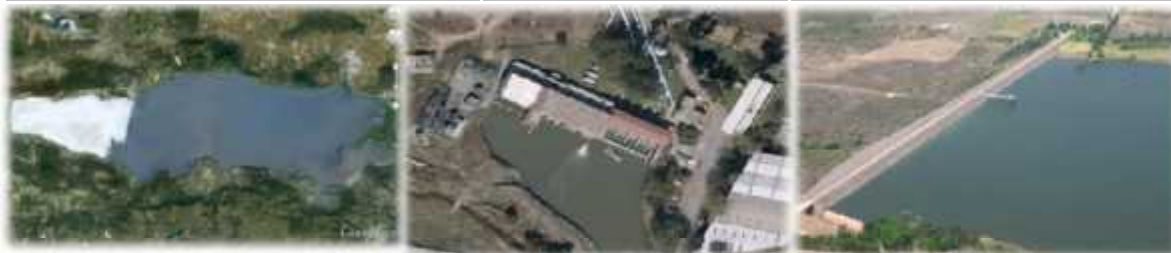
Planta de bombeo Chapala Planta de bombeo No. 2 Presa Ing. Elías González
