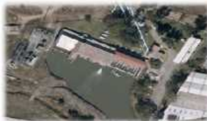
Planta de bombeo No. 2
