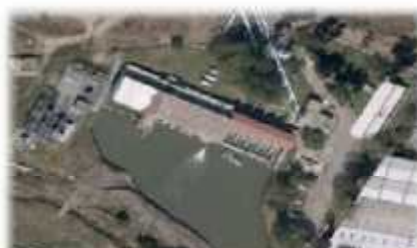
Planta de bombeo No. 2
