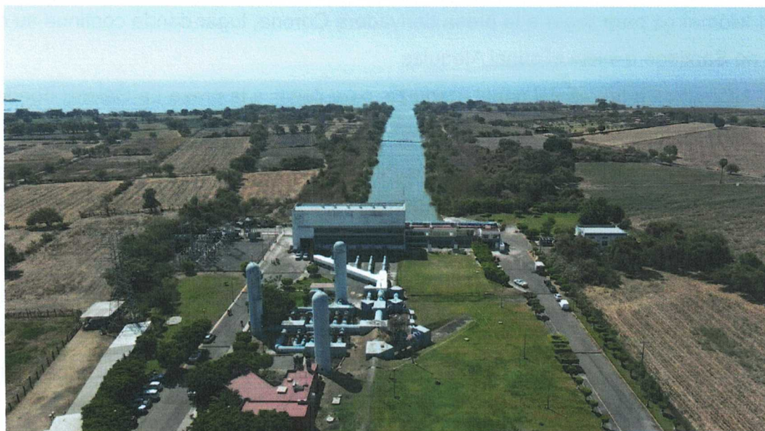
Figura 3. Fotografía de la planta de bombeo de SIAPA, ubicada en la ribera del Lago de Chapala entre los poblados de San Nicolas de Ibarra y Santa Cruz de la Soledad.
