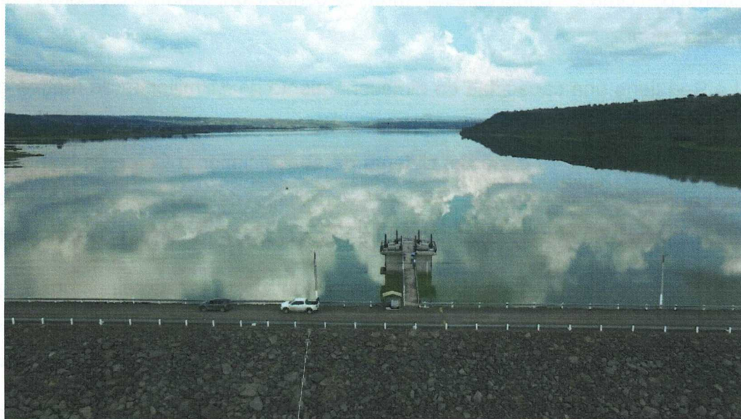
Figura 5. Fotografía de la cortina de la Presa Elías González Chávez.
